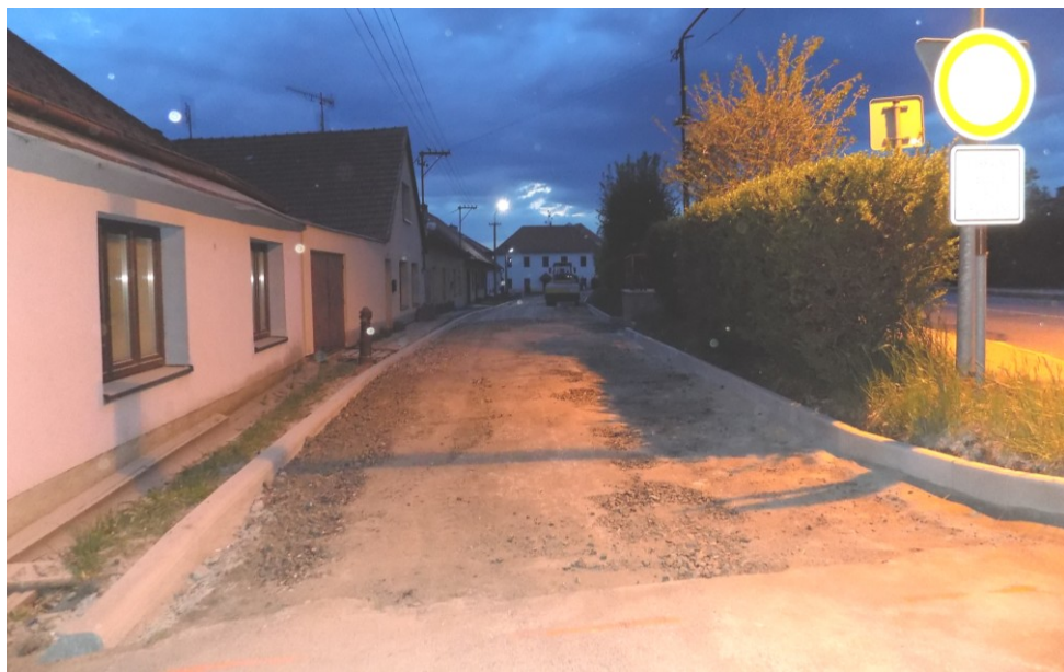
Oprava místní komunikace na návsi
