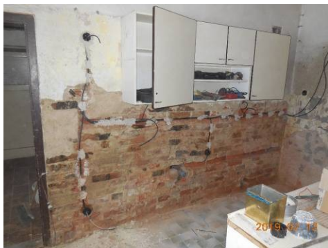
Rozvod nové elektřiny v domě čp. 16.
