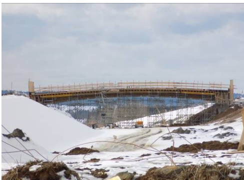
Stavba lávky v Lipí pro pěší a cyklisty.
