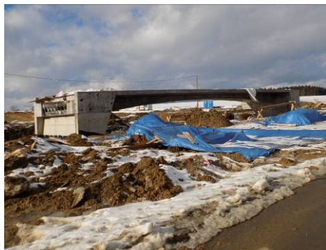
Stavba mostu na Nížkou Lhotu.
