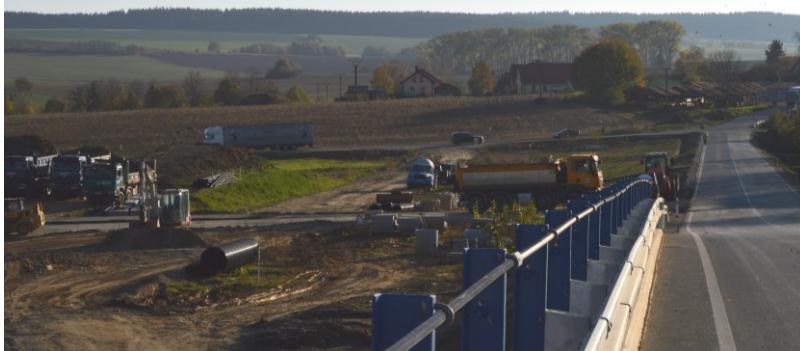
Práce na obchvatu obce - konec října 2019 (foto V. Hřebíková)
